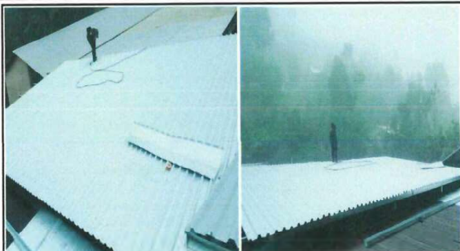
Foto1: Sustitucion de lamina de baja calidad, por lamina troquelada aluzinc, AULA 2 DE PREPRIMARIA
