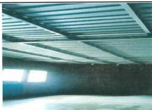
Foto 3: Sustitución de estructura de soporte de metal, por metal,Tubo cuadrado 4x4, chapa 14, AULA 2 DE PREPRIMARIA
