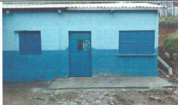
Foto 2. Colocacion de venta de metal
