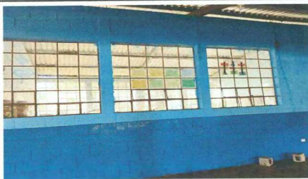
Foto 5. Sustitucion de vidrios de ventana
