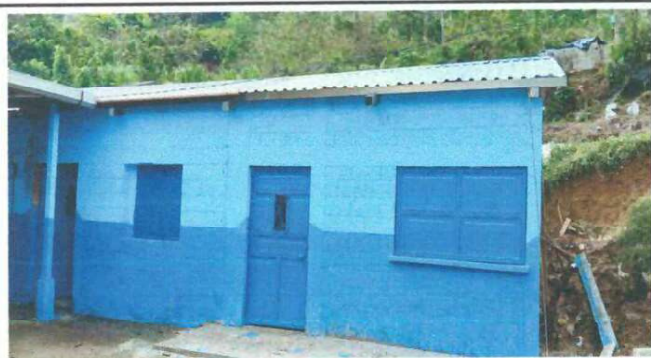
Foto 3. Instalacion de puerta de metal
