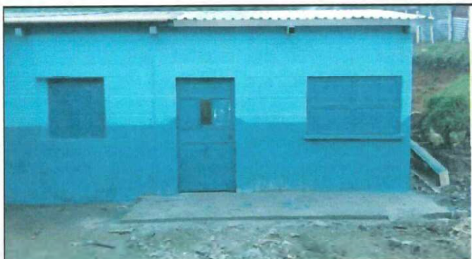
Foto13: Ampliacion y acondicionamiento de Cocina 4x4x3, exterior .
