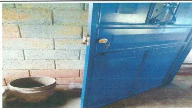
Foto 4. sustitucion de chapas
