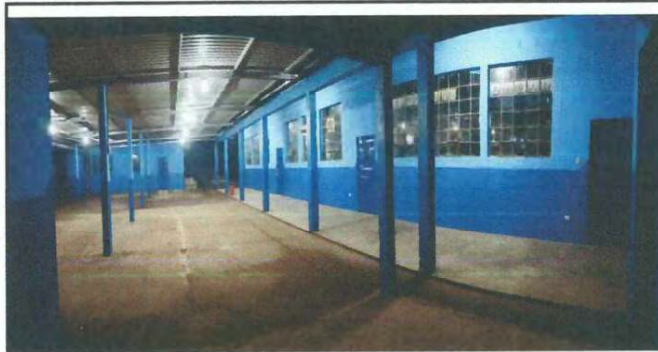
Foto 6. Pintura para el edificio escolar
